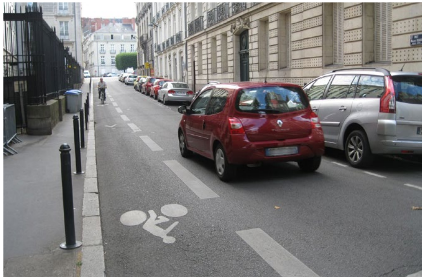
Dans ce cas de rue large l'aménageur a préféré réaliser un marquage séparatif pour réduire visuellement l'emprise dédiée aux véhicules motorisés
