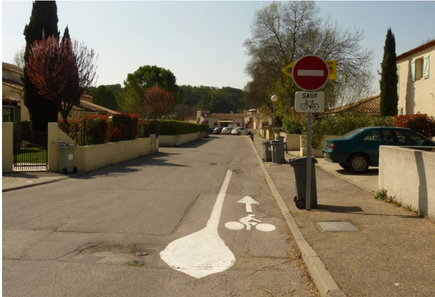
Marquage en début de double sens cyclable, puis rien en section courante pour les rues à faible trafic
